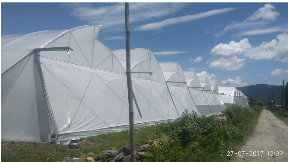
चित्र: Gutter Cemented नेचुरल्ली भेन्टिलेटेड प्लाष्टिक घर
